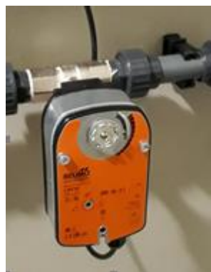
Figura 3: Válvula de segurança
