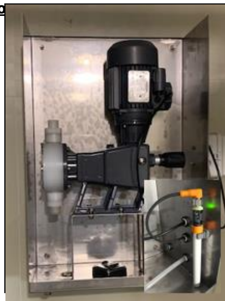
Figura 4: Bomba de ácido sulfúrico
